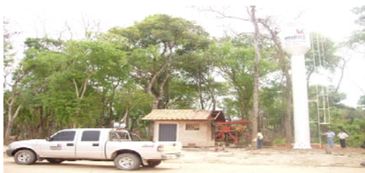
Construcción de Sistemas de Agua Potable
