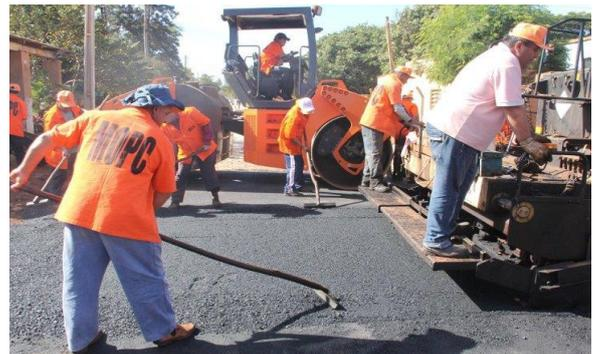
Pavimentación asfáltica sobre empedrado
