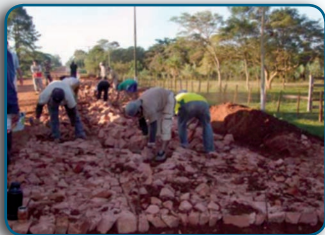
Ejecución de pavimento tipo empedrado.
