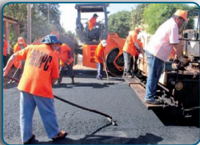
Pavimentación asfáltica sobre empedrado.
