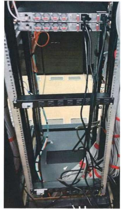
El datacenter 2 presenta una mejor estructura de PDU, si bien no existe una obligación de usar PDUs horizontales o verticales, con la nueva densidad de equipos el uso de PDUs verticales es mucho más eficiente, sin contar que permite una mayor cantidad de equipos conectados, una mejora sustancial para el DC1 sería la instalación de este tipo de PDU.
