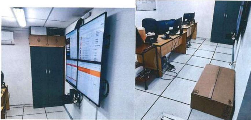
Observación: Requiere un espacio técnico para ir armando equipos y otros ya que potencialmente la sala puede llenarse, esto es respetando una recomendación del estándar TIA 942 donde se designa una sala de montaje especial
