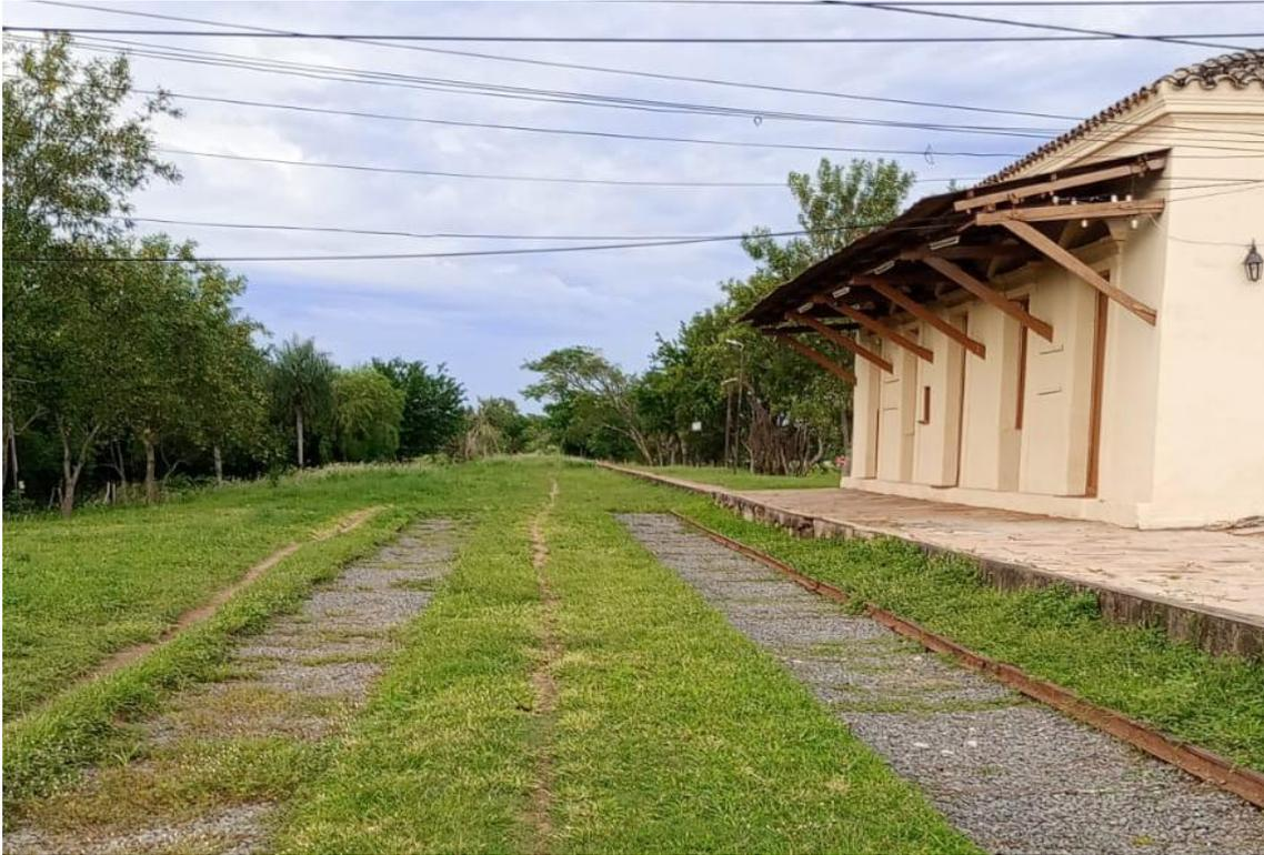
***Ilustración 6: Restos de la superestructura de vía férrea en la estación de Paraguarí***
