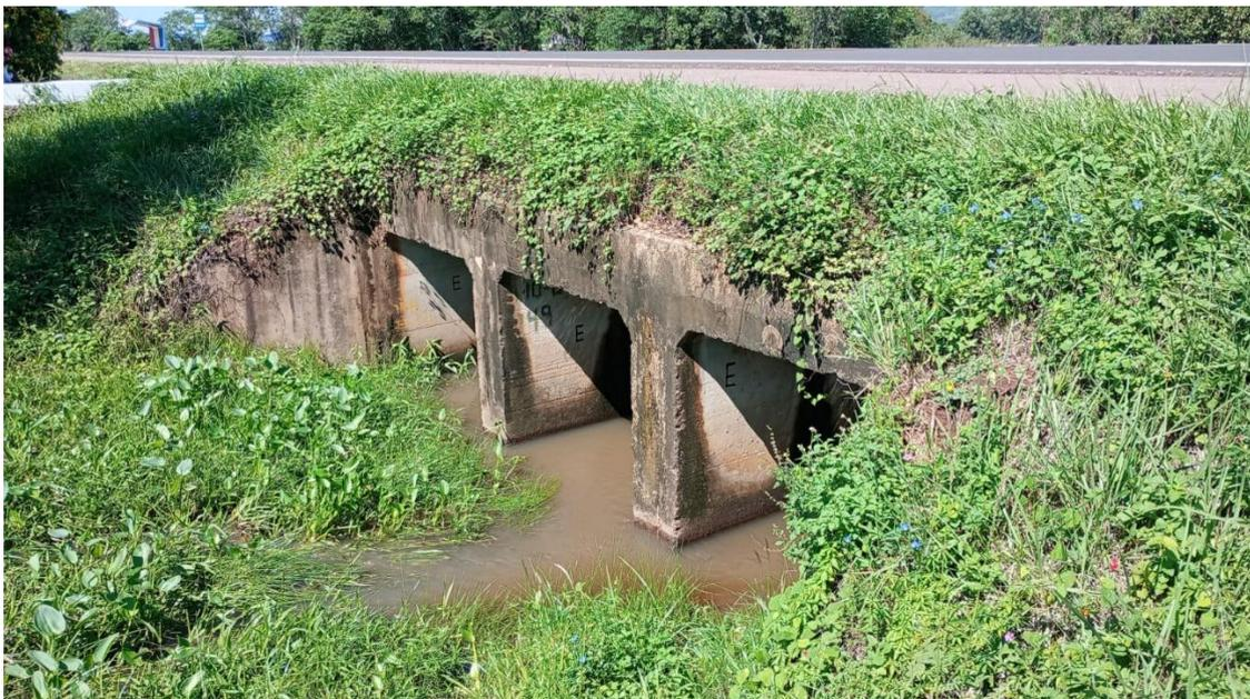
***Ilustración 19: Alcantarilla en carretera adyacente a la plataforma***
