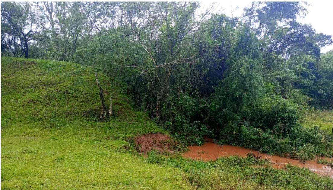
***Ilustración 11: Corte en la plataforma existente para dar paso a un curso de agua***
