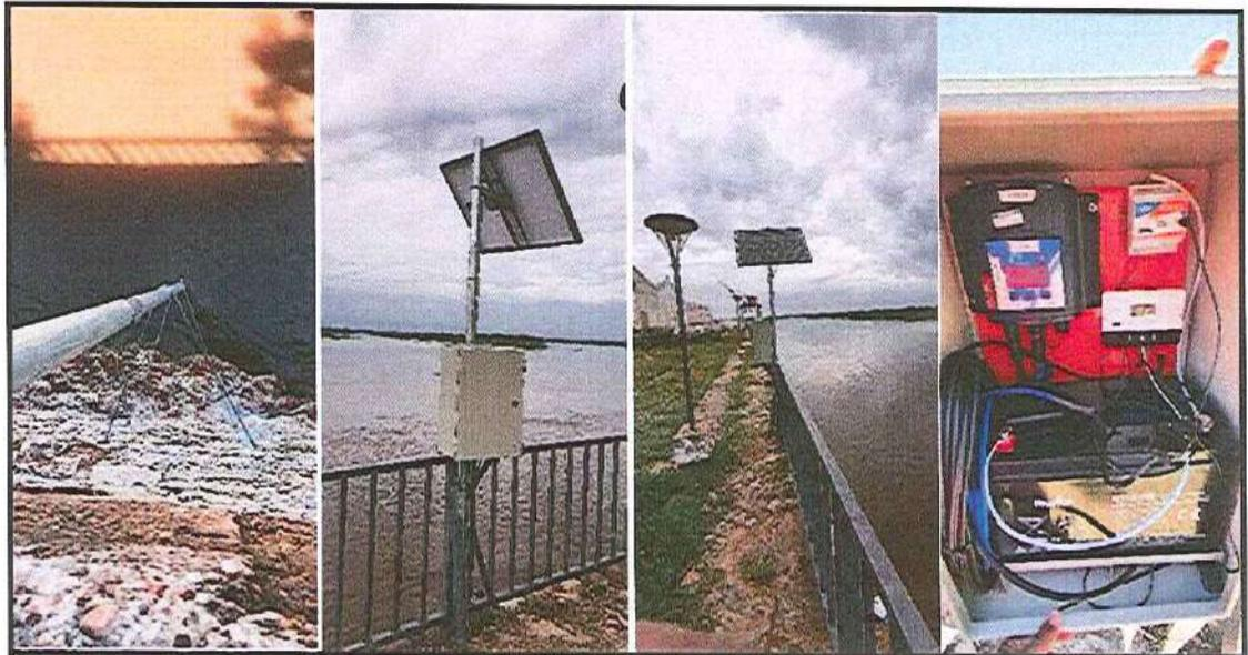
Registro fotográfico de la instalación - Estación hidrométrica Prefectura Naval – Concepción
