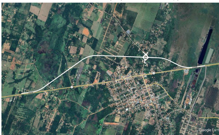
Ilustración 24 – Tramo 6. Variante Arroyos y Esteros (en blanco) y vía existente.
