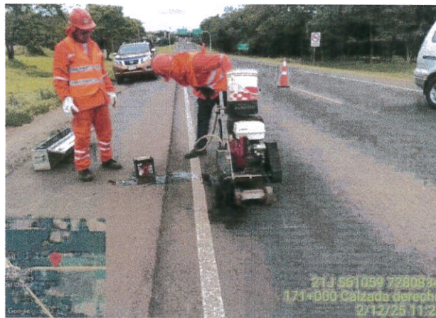
Km 171 - Carril ascendente - Ejecución de calicata.
