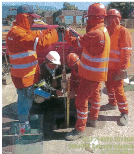
Km 346 - Carril descendente - Ensayo DCP.
