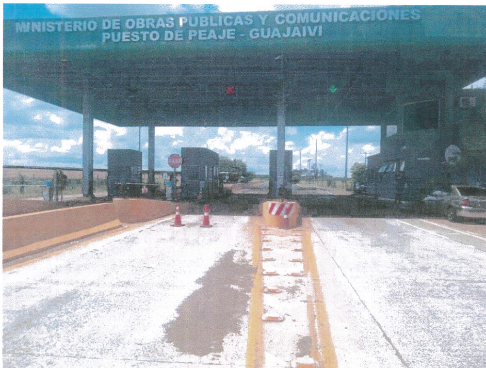
Ilustración 4-2 Estación Peaje Guajaivi.
