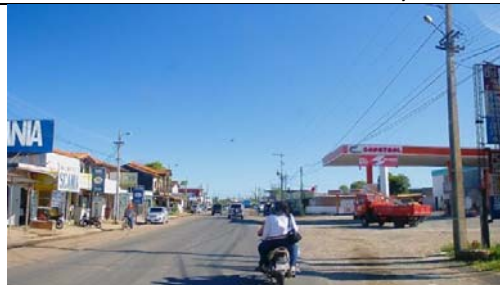
13+000 Zona urbano - comercial Villa Hayes
