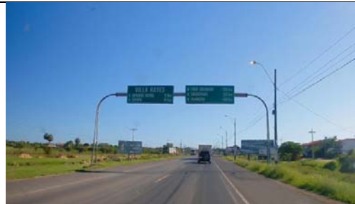
11+400 Pórtico - Ingreso a la localidad de Villa Hayes
