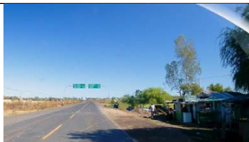
29+550 Pórtico - Casas en franja de dominio a mano derecha
