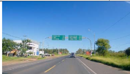
13+900 Pórtico - Salida a la localidad de Villa Hayes
