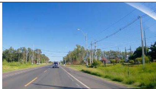
14+200 Subestación transformadora Ciudad Nueva (ANDE) a mano derecha - Cruce LMT aérea
