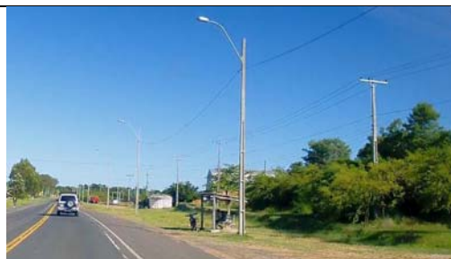
17+425 Refugios a reemplazar y luminarias a trasladar
