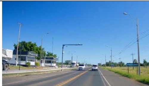
6+750 Patrulla caminera - Puesto de control de pesaje
