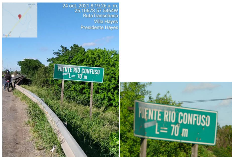
Foto 39 y 40. Puente sobre el Río Confuso.
