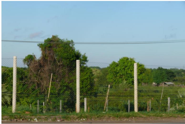
Foto 7. Margen izquierda de ruta 09, pasando el Puente.
