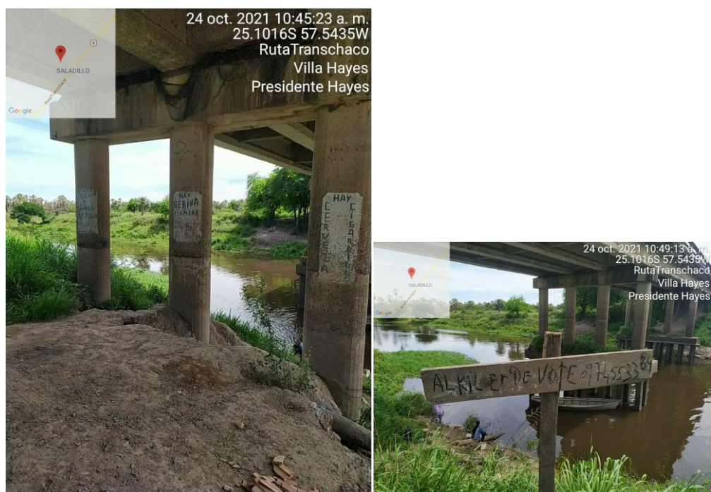
Foto 53 y 54. Bajo el puente sobre el Río Confuso.
