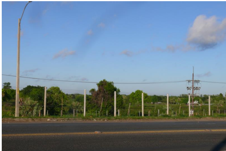
Foto 8. Margen izquierda de ruta 09, pasando el Puente
