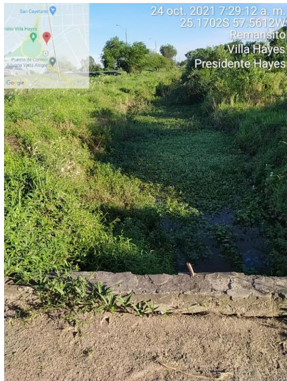
Foto 24. Canal de drenaje con camalotes y plantas acuáticas enraizadas.
