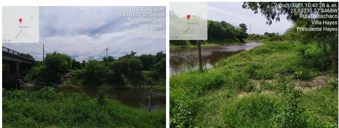
Foto 51 y 52. Vista de la margen derecha de la ruta 09, Río Confuso.
