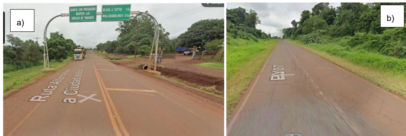
Figura 2: Imágenes de Referencia del Actual Estado Vial de la Ruta PY07 en ambos tramos a) Corredor de Exportación y b) Tramo Antiguo
