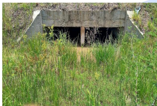
Fotografía N° 3: Paso de fauna Lote 1
