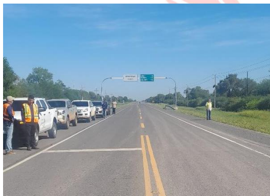
Fotografía N° 1: Tramo correspondiente a Línea 1
