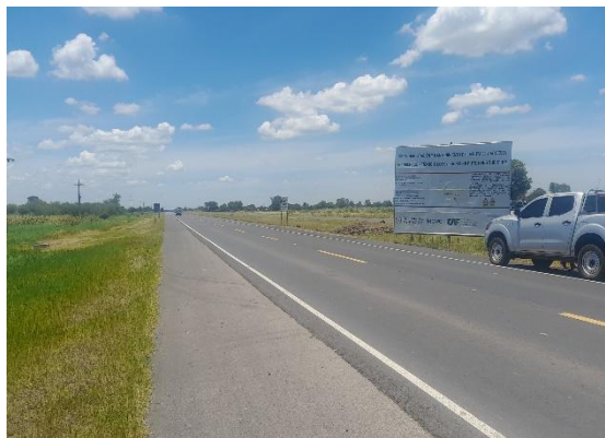
Fotografía N° 1: Inicio del Lote 2 del proyecto
