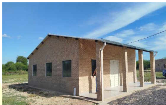
Fotografía N° 4: Construcción de Puesto Policial culminado y equipado
