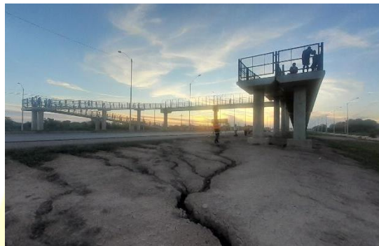
Fotografía N° 7: Puente peatonal sobre el tramo
