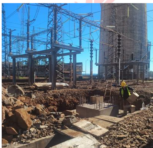
Fotografías N° 14 y 15: Construcción de fundaciones en obras de Subestación (SE) Acaray
