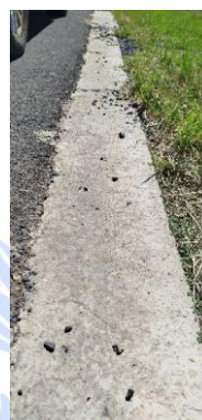
Fotografía N° 4: Refuerzo de calzada con hormigón armado
