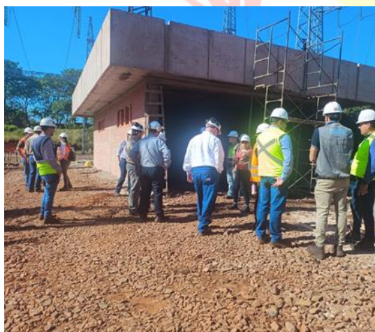
Fotografía N° 18 : Construcción casa de relés 2, en etapa de culminación
