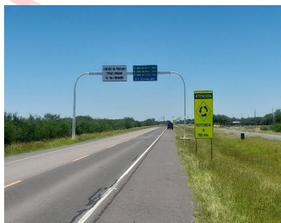
Fotografía N° 6: Pórticos de señalización vertical
