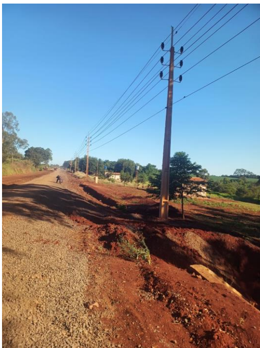
Fotografía N° 9: Con Base Granular y columnas de la ANDE en la franja de dominio.
