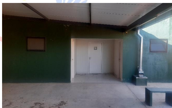
Fotografía N° 6: Baños del Museo construidos
