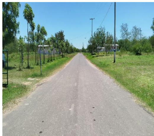
Fotografía N° 2: Otra vista de accesos a comunidades
