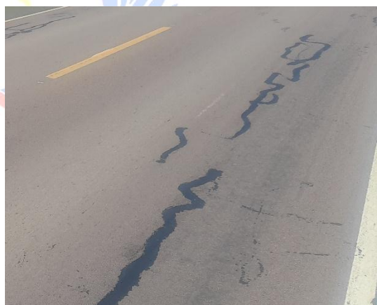
Fotografía N° 6: Trabajos de sellado en el pavimento
