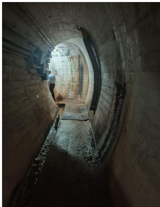
Fotografía N° 13: Galería de inspección - Represa Acaray
