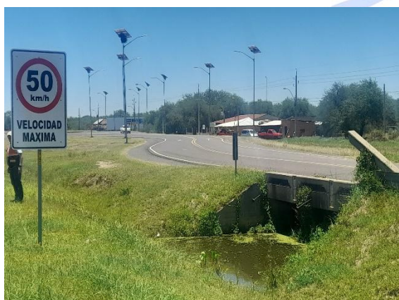
Fotografía N° 5: Trabajos de Limpieza de Franja de Dominio
