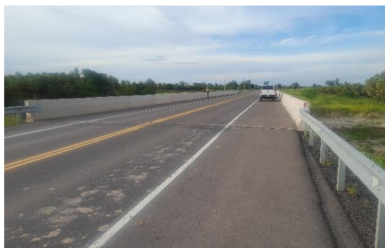
Fotografía N° 3: Puente sobre el trazado del tramo
