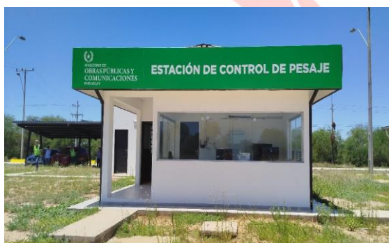
Fotografía N° 5: Estación de control de pesaje culminado y equipado a ser entregado al MOPC
