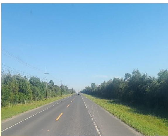
Fotografía N° 6: Estado actual de un tramo del Acceso a Loma Plata
