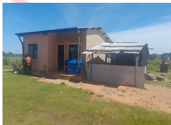
Fotografía N° 4: Construcción de casa con cañerías para tendido de la red de agua corriente en la Comunidad Indígena “Arca”- Pueblo Quom.
