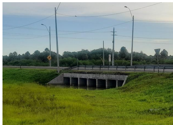
Fotografía N° 2: Obras de alcantarilla en el tramo
