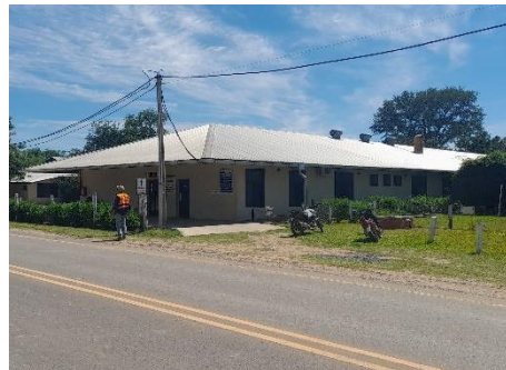
Fotografía N° 10: Vista de parte de infraestructura de salud beneficiada con el acceso.
