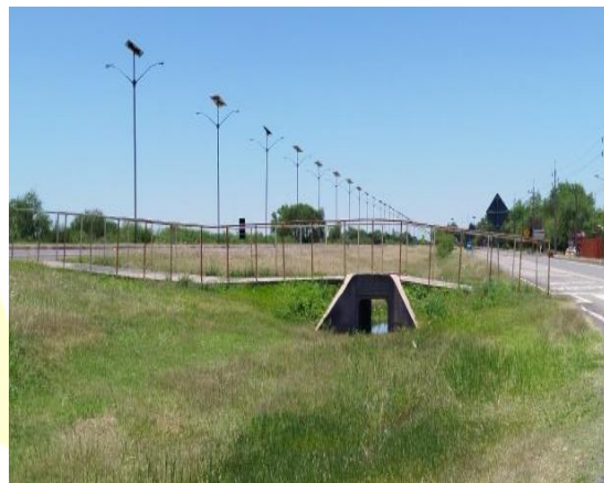
Fotografía N° 4: Sistema de Drenaje con pasarela e iluminación con columnas de paneles solares
