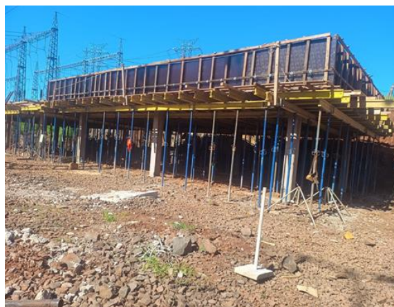
Fotografía N° 17: Construcción de Casa de relés 1
