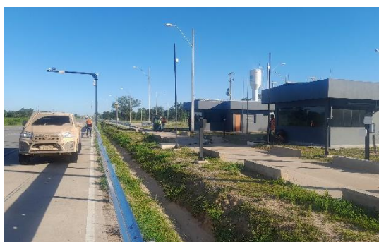
Fotografía N° 3: Estación de control de pesaje culminado y equipado a ser entregado al MOPC
