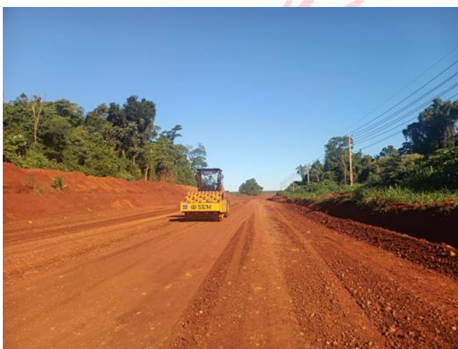
Fotografía N° 1: Compactación del suelo, subrasante mejorada.
