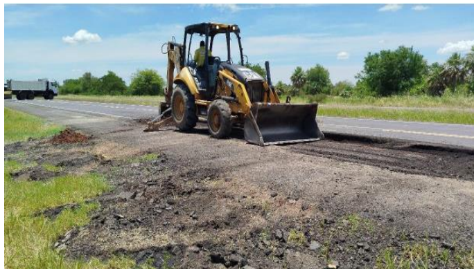
Fotografía N° 3: Trabajo de mantenimiento de calzada en el lote 1.
