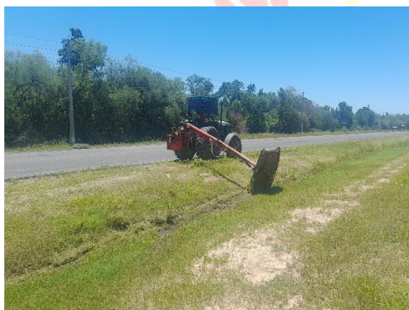
Fotografía N° 5: Trabajos de Limpieza de Franja de Dominio
