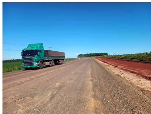
Fotografía N° 6: Con base asfáltica.
