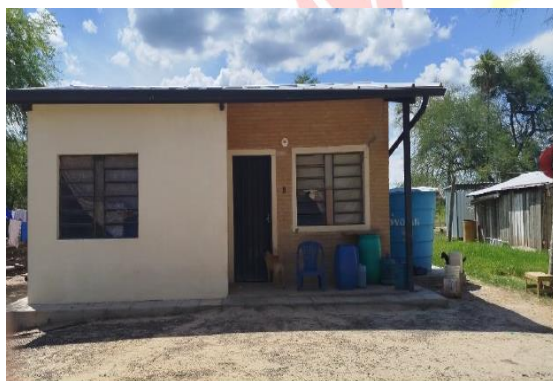
Fotografía N° 3: Obras de construcción de casas a la Comunidad Indígena "Kemha Yat Sepo"
