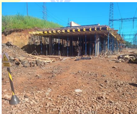
Fotografía N° 19 : Construcción de casa de relés 3, en ejecución.
