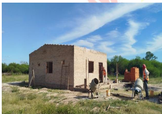
Fotografía N° 5: Construcción de Puesto de salud en ejecución
