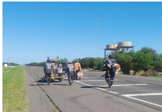
Fotografía N° 2: Trabajos de mantenimiento de pavimento y señalización horizontal
